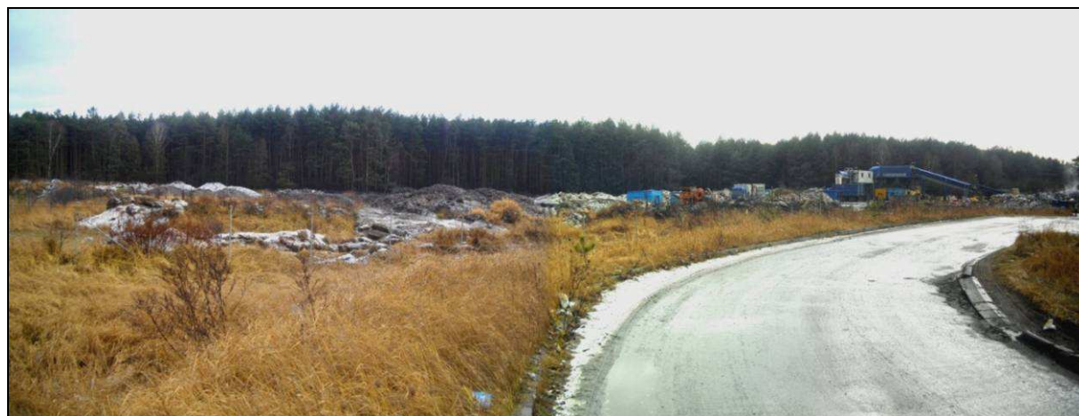
Fot. zrehabilitowana kwatera składowiska oraz zbiornik na odcieki
